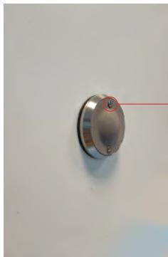
La sonde n'est pas correctement fixée au mur et l'étanchéité n'est pas garantie.
